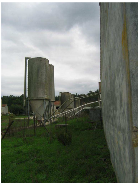
Fotografia 3.15 - Vista para os silos no topo norte da exploração.
