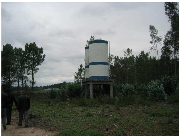
Fotografia 3.9 - Depósitos de água.
