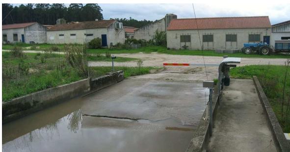
Fotografia 3.3 - Rodilúvio (vista de norte para sul).
