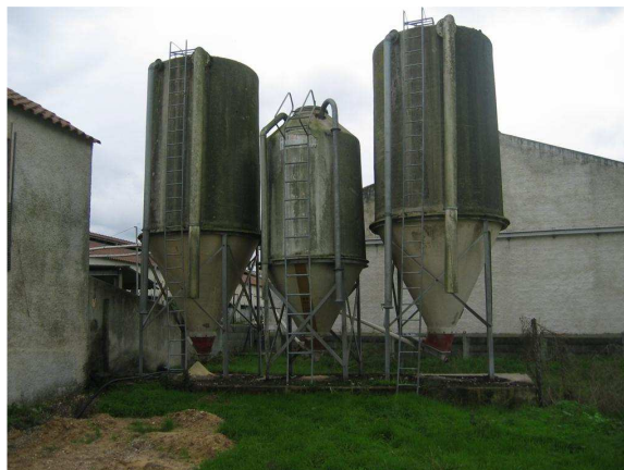
Fotografia 3.14 - Silos no topo do pavilhão 7C.
