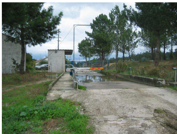
Fotografia 3.4 - Rodilúvio e portaria (vista de sul para norte).
