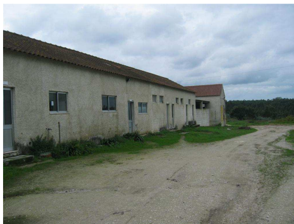
Fotografia 3.6 - Vista para o edifício social e cais de embarque.
