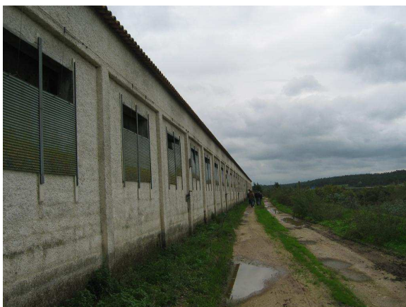
Fotografia 3.17 - Vista para o pavilhão 7A e acesso interno.
